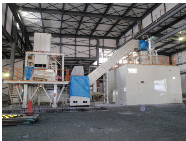
写真7 1期工事据付完了
