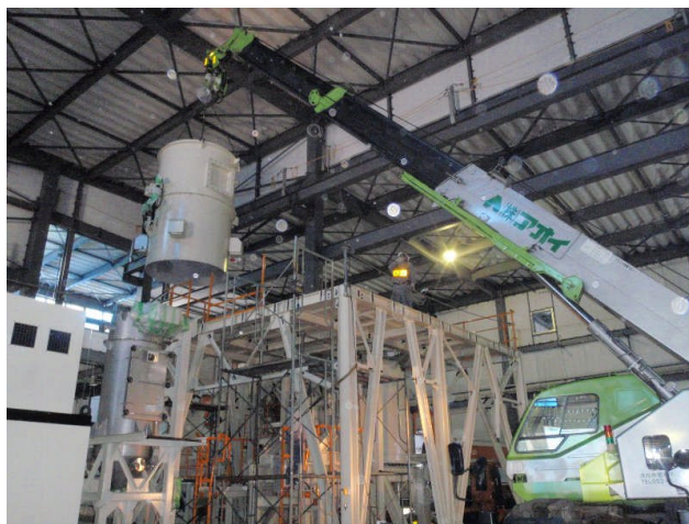
写真6 細破碎工程据付
